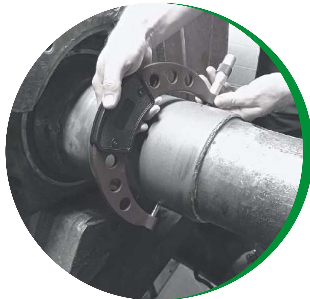
Восстановление шейки вала перерабатывающего котла
