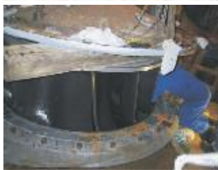
Покрытие турбинных лопаток
